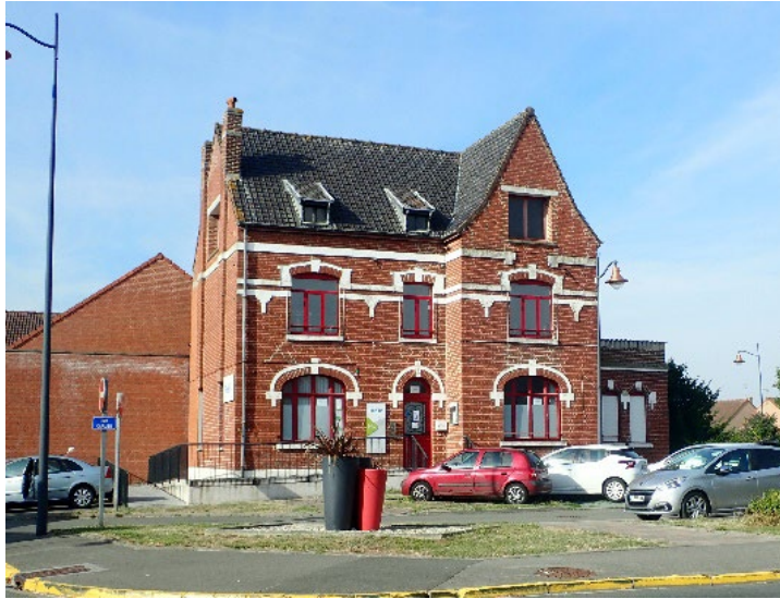
Maison de santé d'Hulluch, rue du général Leclerc
