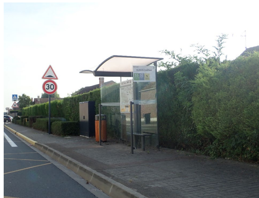
Arrêt de bus interurbain et scolaire – Rue Rayère
